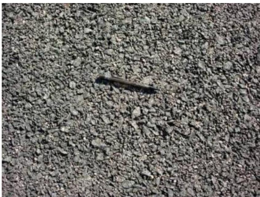
Figura 58 – Concreto asfáltico poroso
