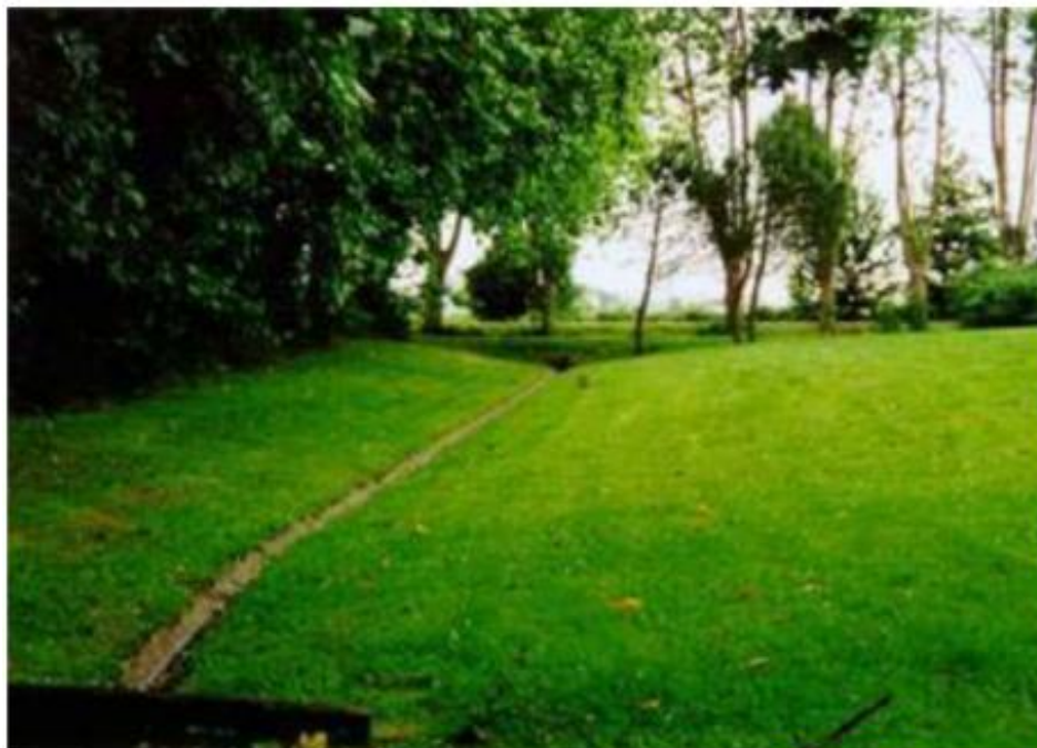
Figura 44 – Vala de infiltração com canaleta de concreto
