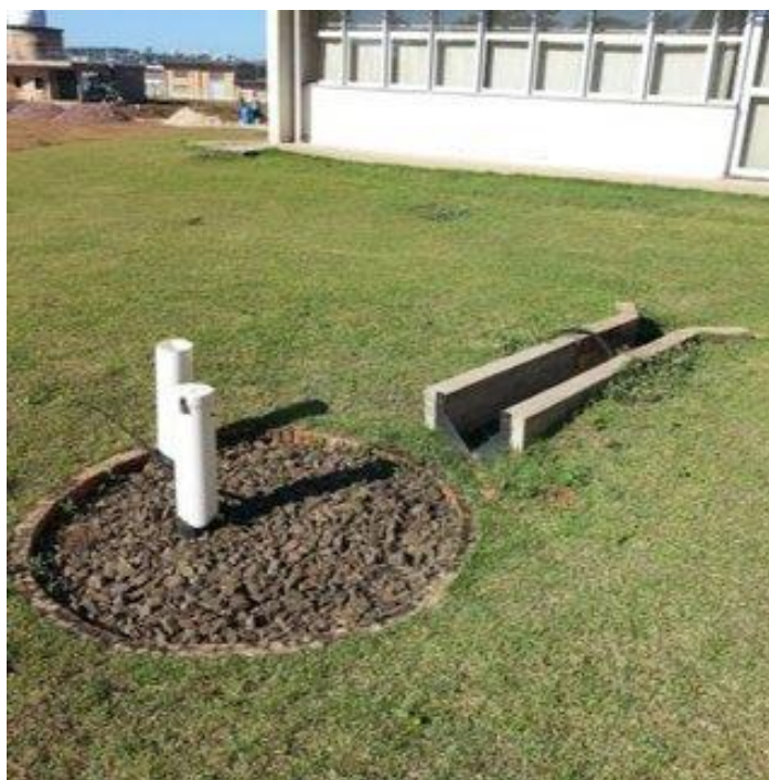
Figura 46 – Poço de infiltração Campus UFSCAR
