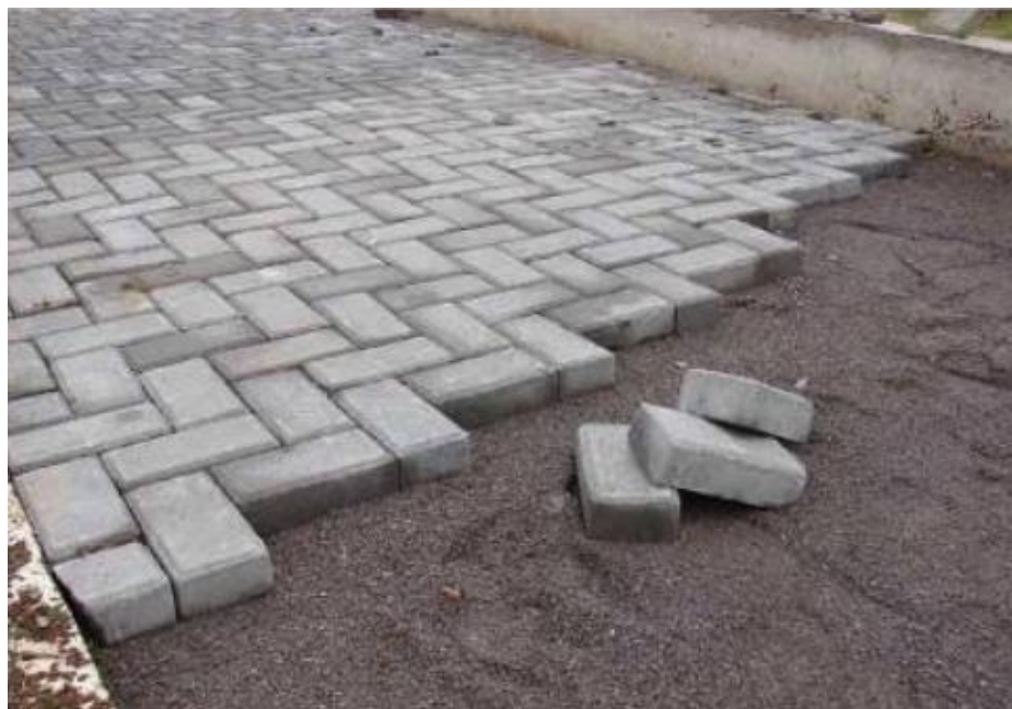
Figura 56 – Blocos de concretos intertravados assentados sobre berço de areia
