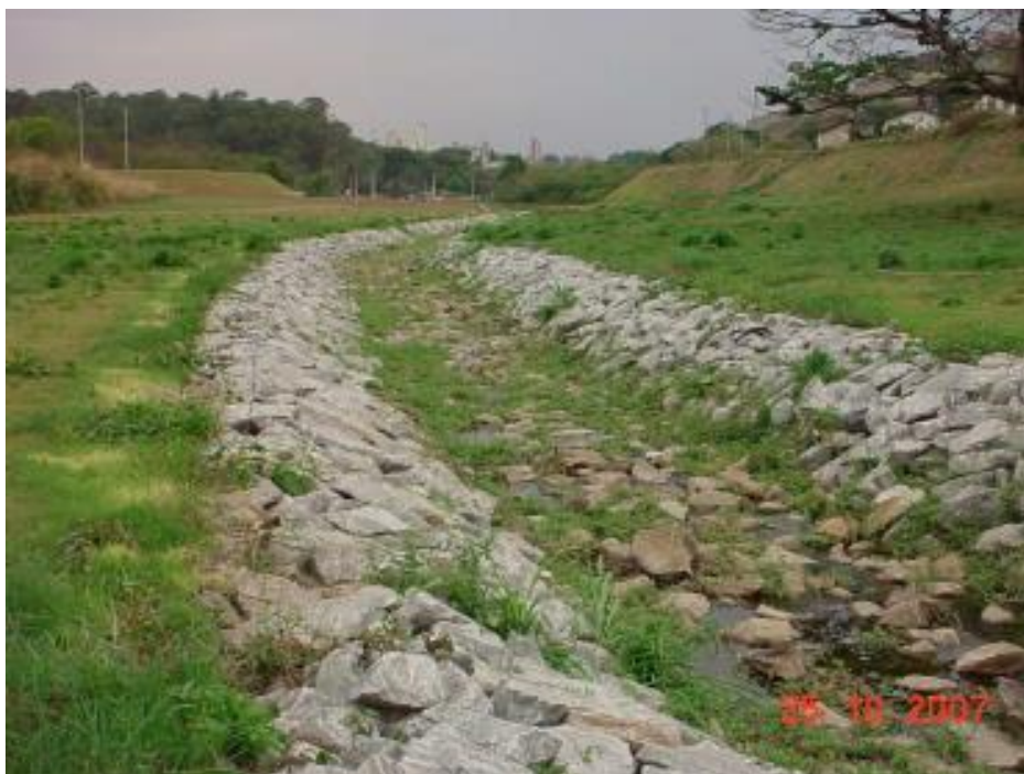
Figura 62 – Enrocamento utilizado para revestimento do leito e das margens do córrego
