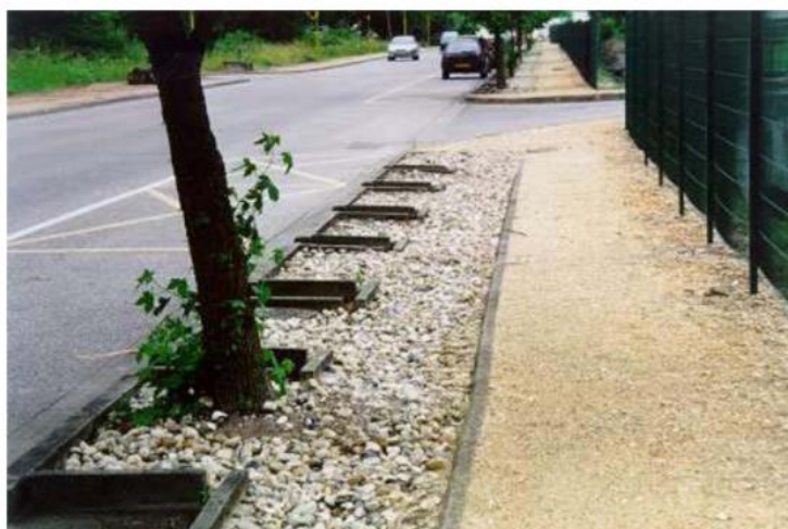
Figura 42 – Trincheira de infiltração em passeios
