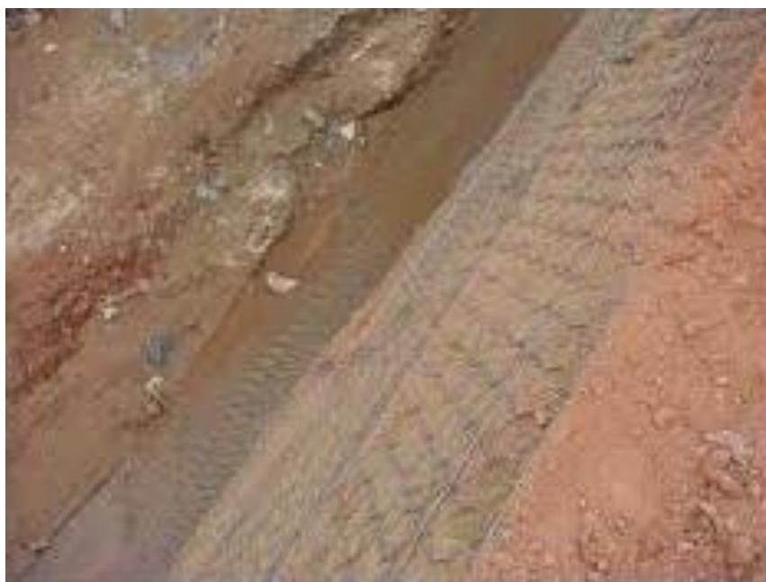
Figura 61 – Terramesh (tela vegetal) utilizada para a contenção de taludes em córrego
