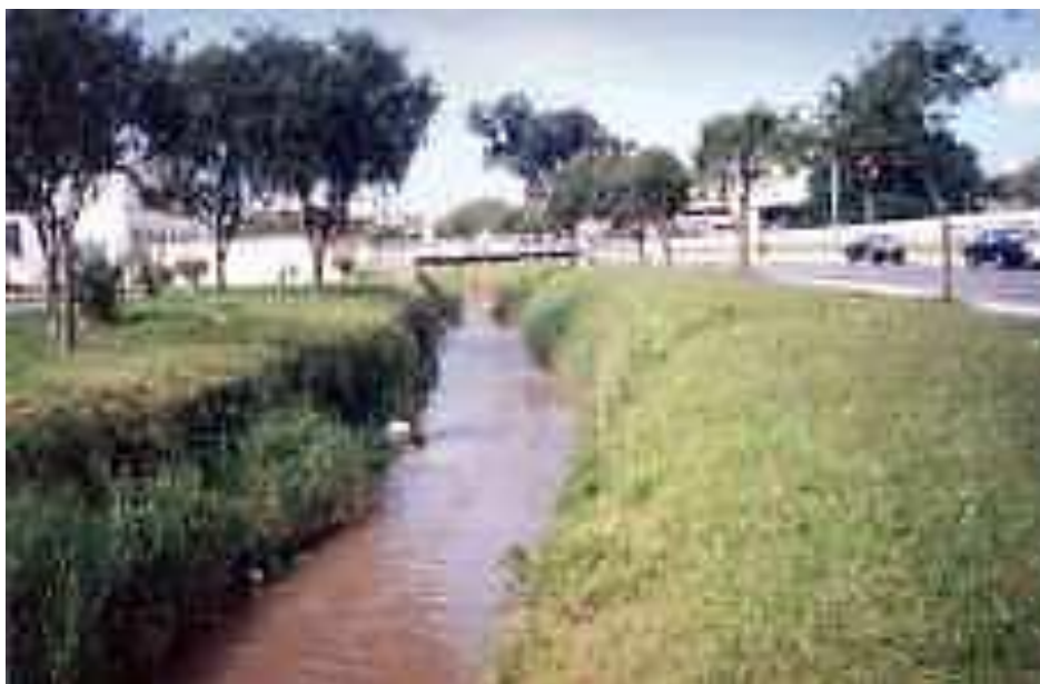
Figura 60 – Proteção de margens com canteiro lateral
