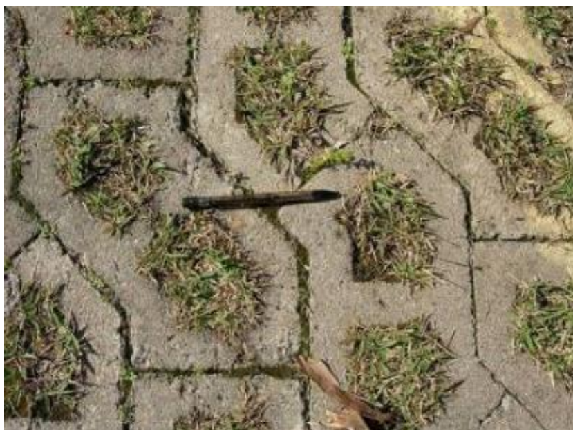
Figura 54 – Blocos de concreto pré-moldado vazados, preenchidos com gramíneas
