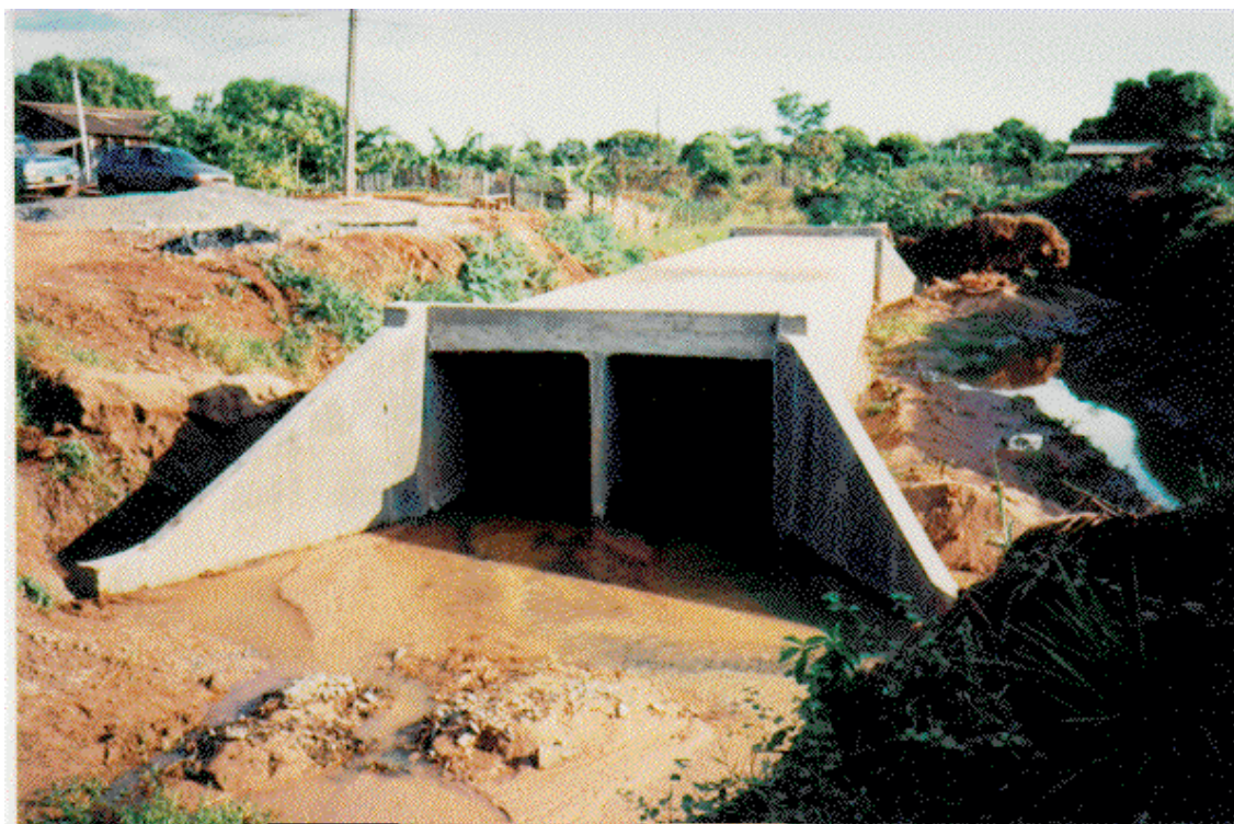
Figura 39 – Exemplo de bueiro: bueiro celular duplo de seção quadrada
