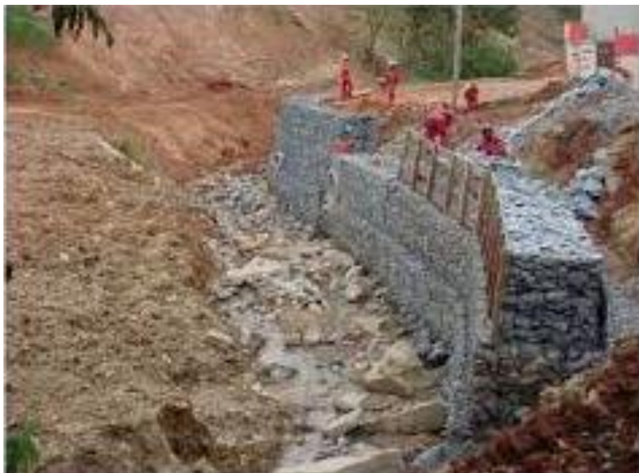
Figura 63 – Gabiões utilizados para a contenção de encostas
