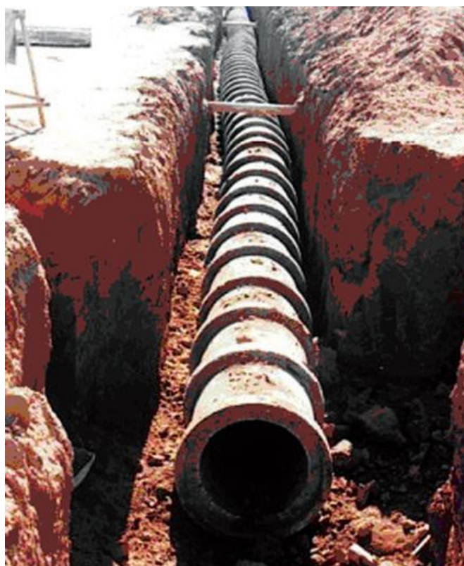
Figura 38 – Galeria de drenagem
